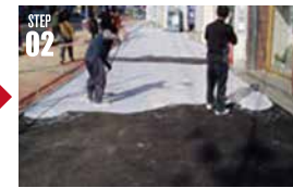
[2. 프라이머 도포 (콘크리트 마감시)]
